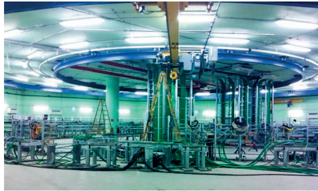
Abbildung 6: MedAustron – Beschleunigungsstrecke für schwere Teilchen (Rohbau)
