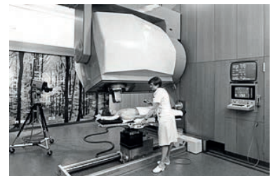
Abbildung 1: Kreisbeschleuniger (Betatron): 1940 entwickelt und bis in die 80er Jahre betrieben. Indem Teilchen in einer Kreisbahn beschleunigt wurden, erreichte die medizinische Anwendung Energien von bis zu 40 MeV (Megaelektronenvolt), in der Technik bis zu 300 MeV. Abgelöst wurde das Betatron durch den Linearbeschleuniger.
